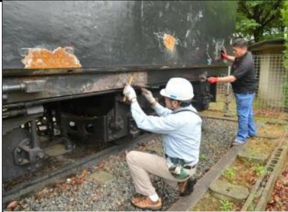
最近、傷みが目立つようになってきた車体。傷んだ部分の塗装を剥がして補修に取り掛かりました。が、程なくして小雨がパラパラ…作業を断念せざるを得ませんでした(T\_T)
